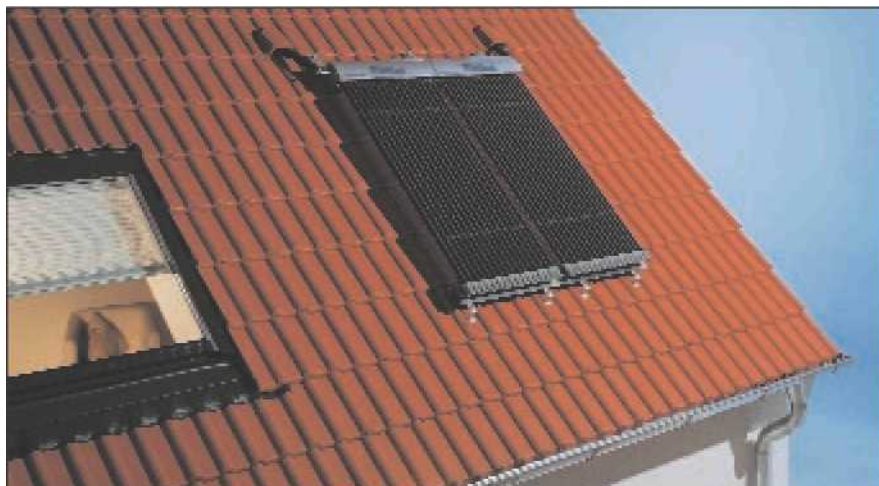
Установка трубчатого коллектора auroTHERM exclusiv VTK 550 на скатной крыше
